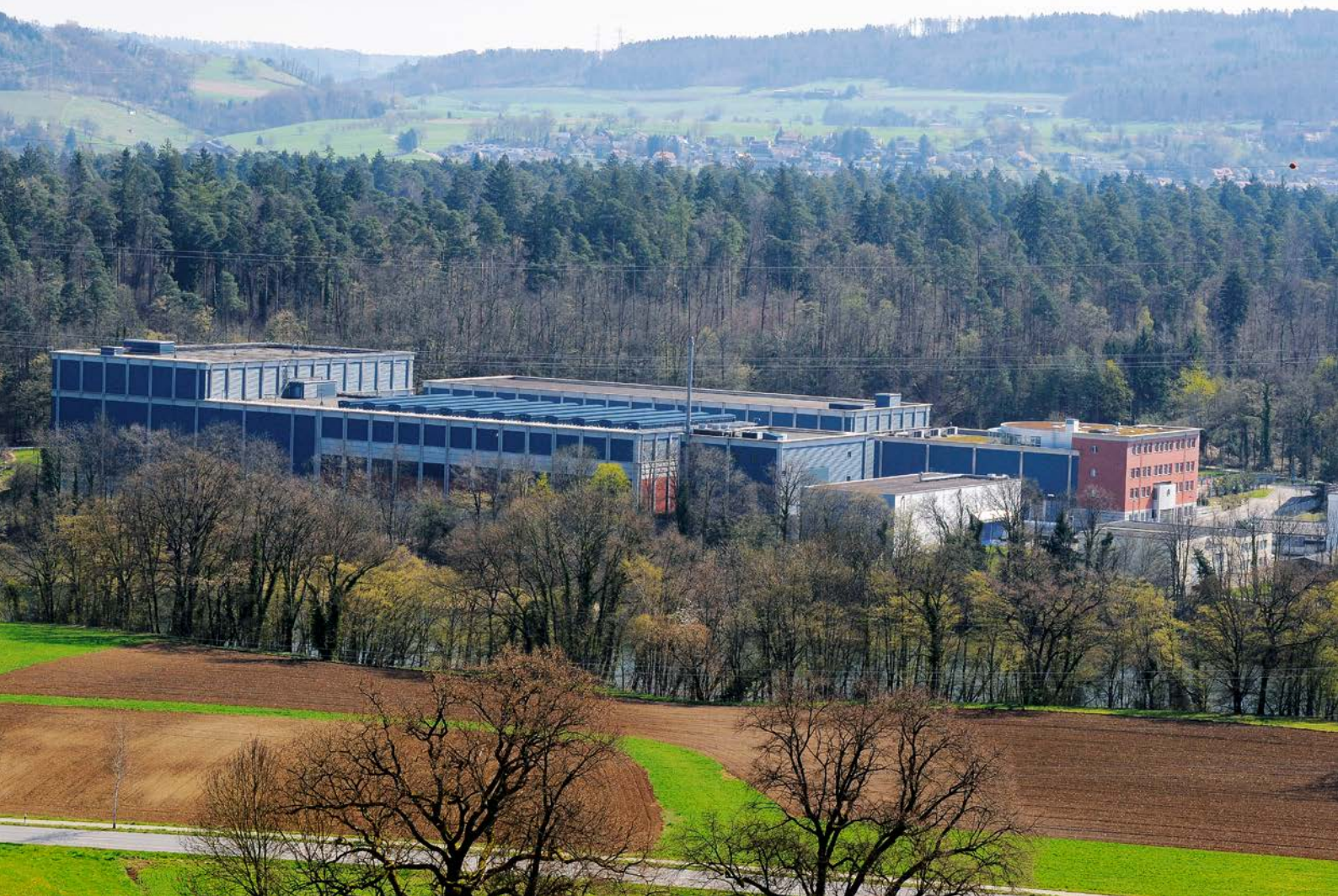
Zentrales Zwischenlager der Zwiilag in Würenlingen. Foto: ENSI
