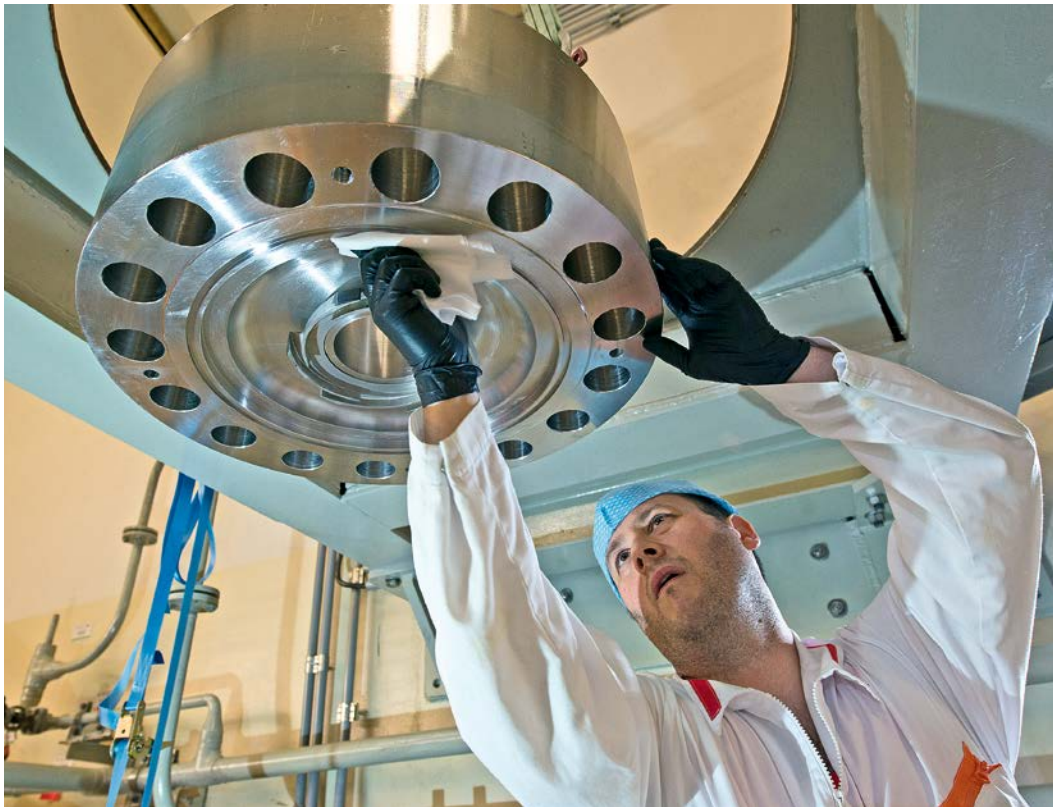
Umbau der Hochdruck- Förderpumpe Foto: KKG
