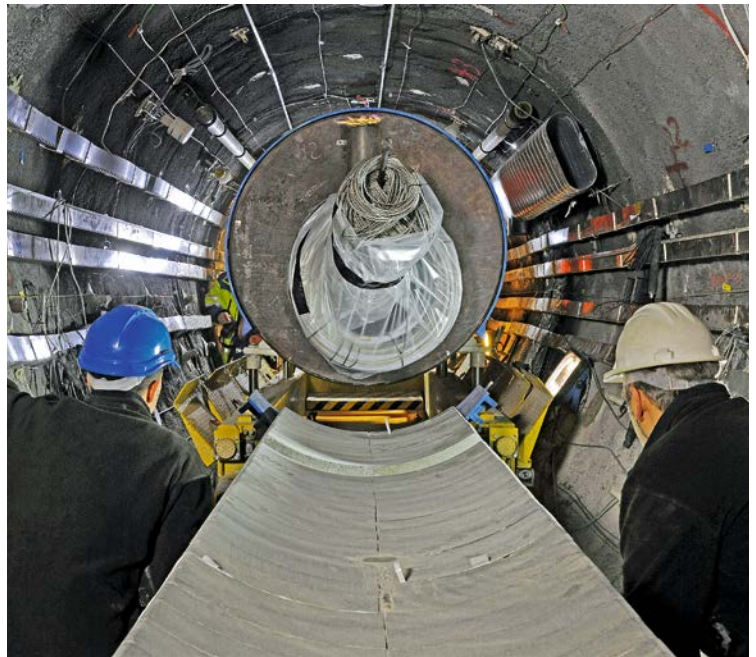
Einbau des Testbehälters. Foto: Comet
