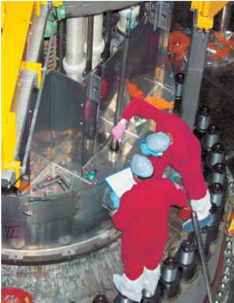
Arbeiten am Deckel des Reaktordruck- behälters im KKW Beznau.
