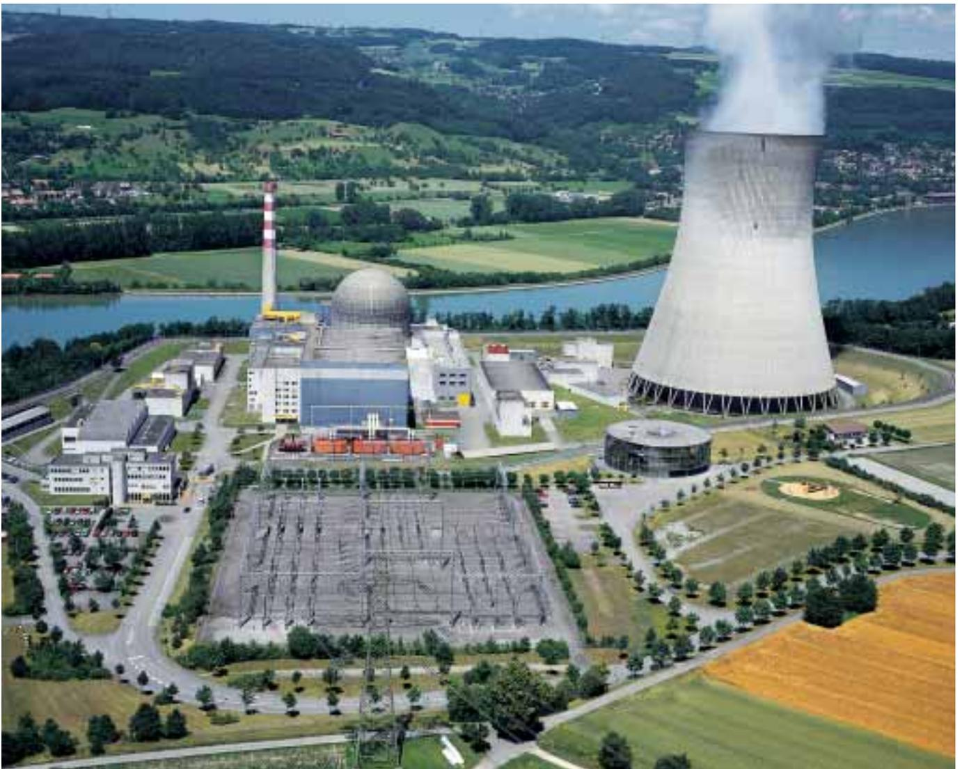
An mehreren heissen Tagen im Juni und Juli musste infolge der hohen Kühlwassertemperaturen die Reaktorleistung reduziert werden. Im Zusammenhang mit dem Netzausfall in Italien am 28. September 2003 wurde zur Gewährleistung der Netzstabilität und der Versorgungssicherheit die Reaktorleistung auf 70% reduziert.
